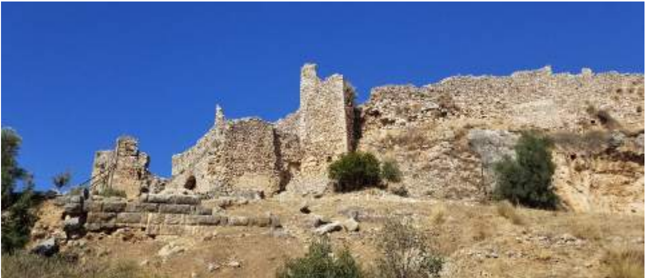
Resim 4 – İç Kale eteğindeki bosajlı teras duvarları
