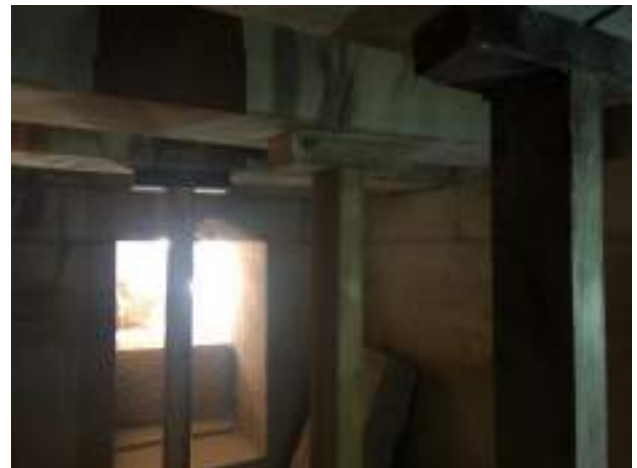
Resim 3 – Batı mezar odası kirişlerinin ahşapla desteklenmesi
