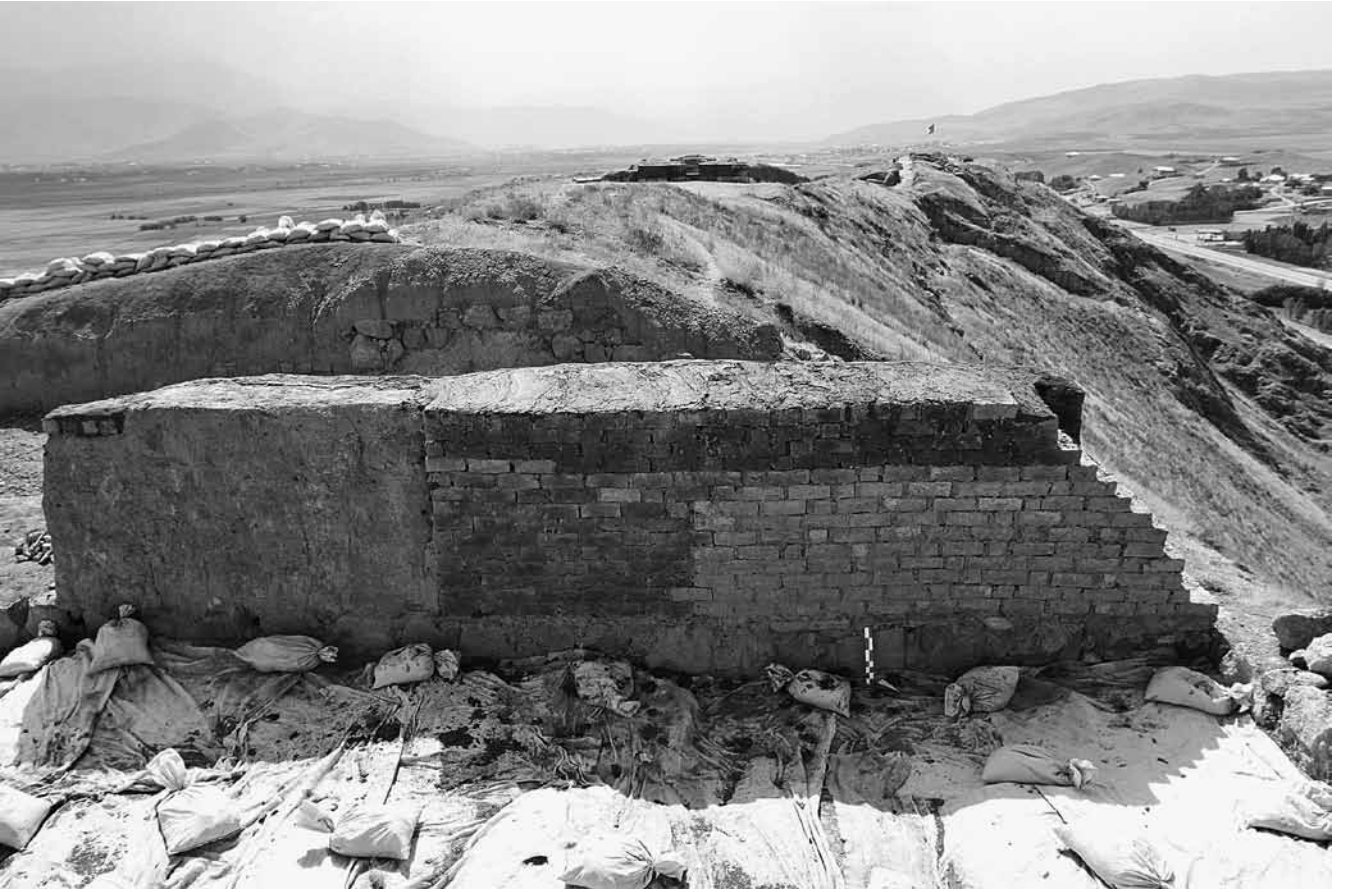
Van/Çavuştepe – I ve II Nolu Depo Odaları Arasındaki Bölme Duvarının Restorasyon Sonrası Durumu
