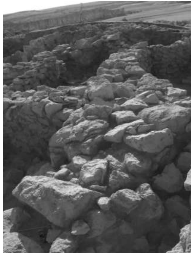
İç kale savunma duvarı dış sırası ve kule
