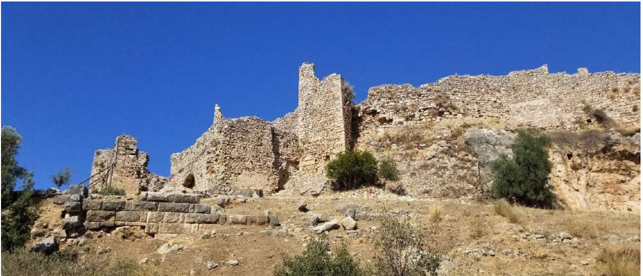
Resim 4 – İç Kale eteğindeki bosajlı teras duvarları
