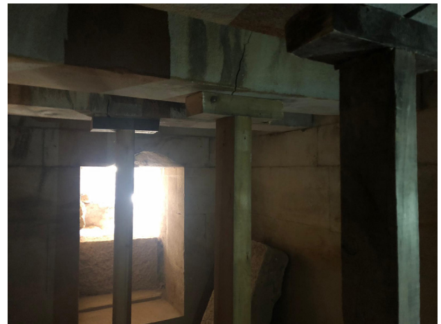
Resim 3 – Batı mezar odası kirişlerinin ahşapla desteklenmesi
