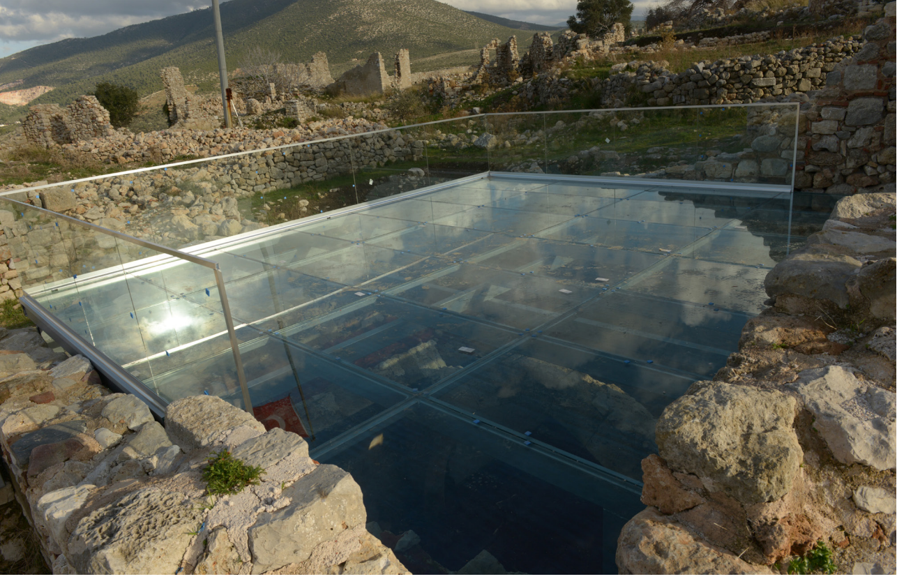
Resim 6 – İç Kale’de yer alan sarnıcın koruma çatısı
