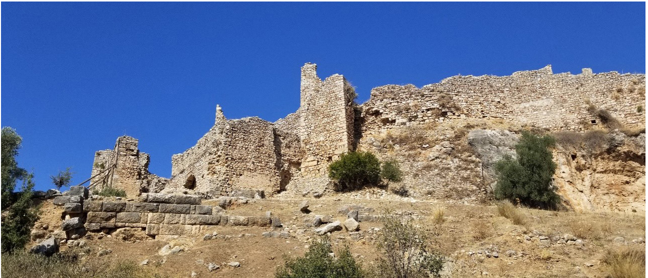
Resim 4 – İç Kale eteğindeki bosajlı teras duvarları
