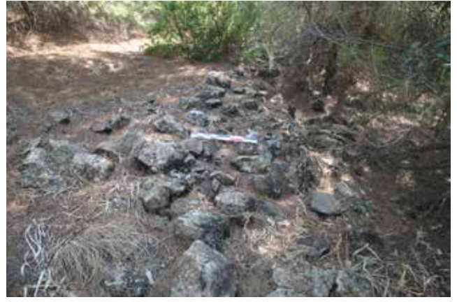
Res. 10 – Güneybatı yamaçtaki sur duvarı kalıntıları
