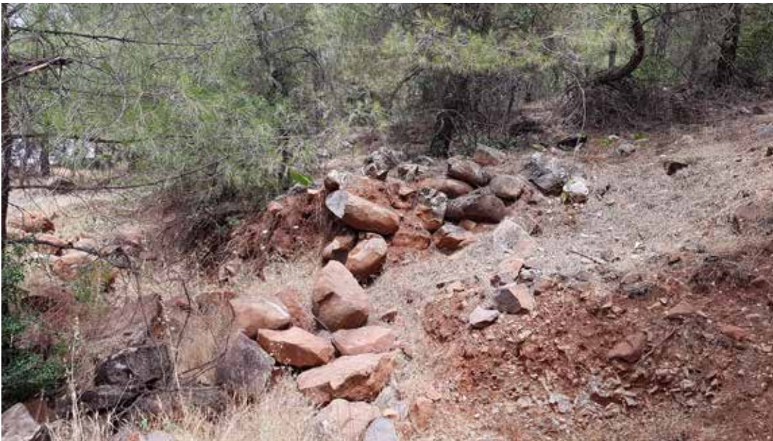
Res. 8 – Çiçektepe Mevkii'nde tahrip edilmiş Hitit duvarı
